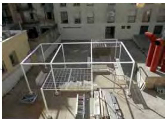
Pérgola para acondicionamiento del patio de manzana
