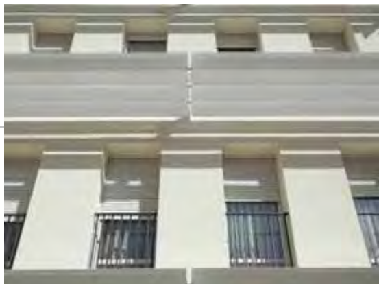
Parasol para protección solar en fachada
